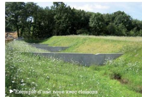
Exemple d'une noue avec cloisons
